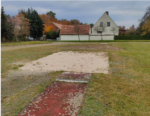
Alte Sportanlage vor der Instandsetzung
