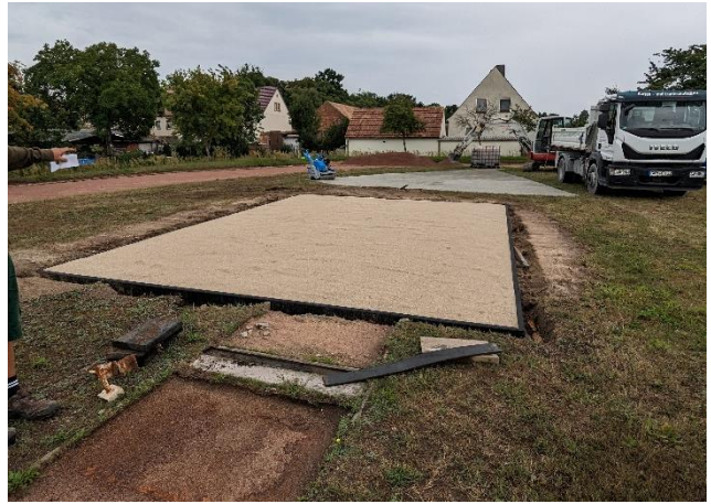
neue Sportanlage während der Bauphase
